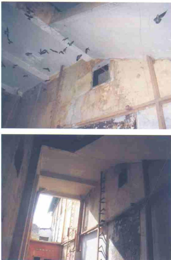
Hình 25. Cửa ra vào nhà chim sơn đen (nhà yến Công Ty Yến Việt). Giếng trời và cửa ra vào nhà chim (ảnh N.K.D.Thu, chụp 21/10/06).
